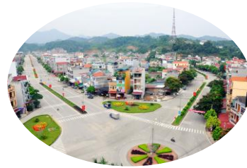
4. Bắc Kạn (53 người/km 2 )
