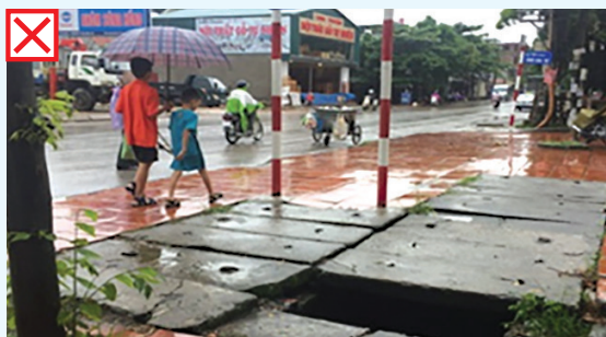
Cống thoát nước công cộng không có nắp đậy, hồ chôn cột điện không lấp
