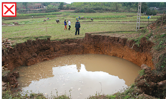
Hố chứa nước không có biển cảnh báo, không có rào chắn, không lấp sau khi sử dụng
