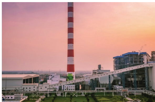
Hình 7.11. Nhà máy Nhiệt điện Hải Phòng (Ảnh: evngenco2.vn)
